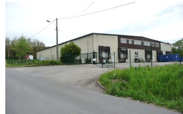
Route de la Mesalière – Revêtements de sol
