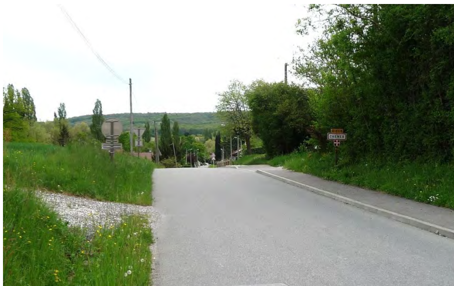
Accès Nord - RD 239 depuis « La Boutique » et la RD 1206
