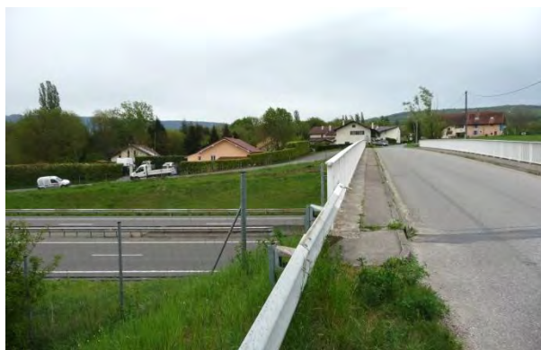
RD 239 au droit de l'autoroute A 40
