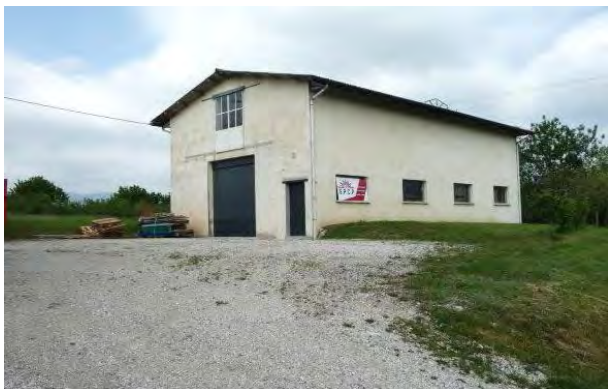
Route de la Boutique – Entreprise de construction
