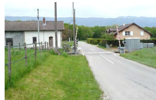
RD 239 au droit de la voie ferrée (Bellegarde-Annemasse)
