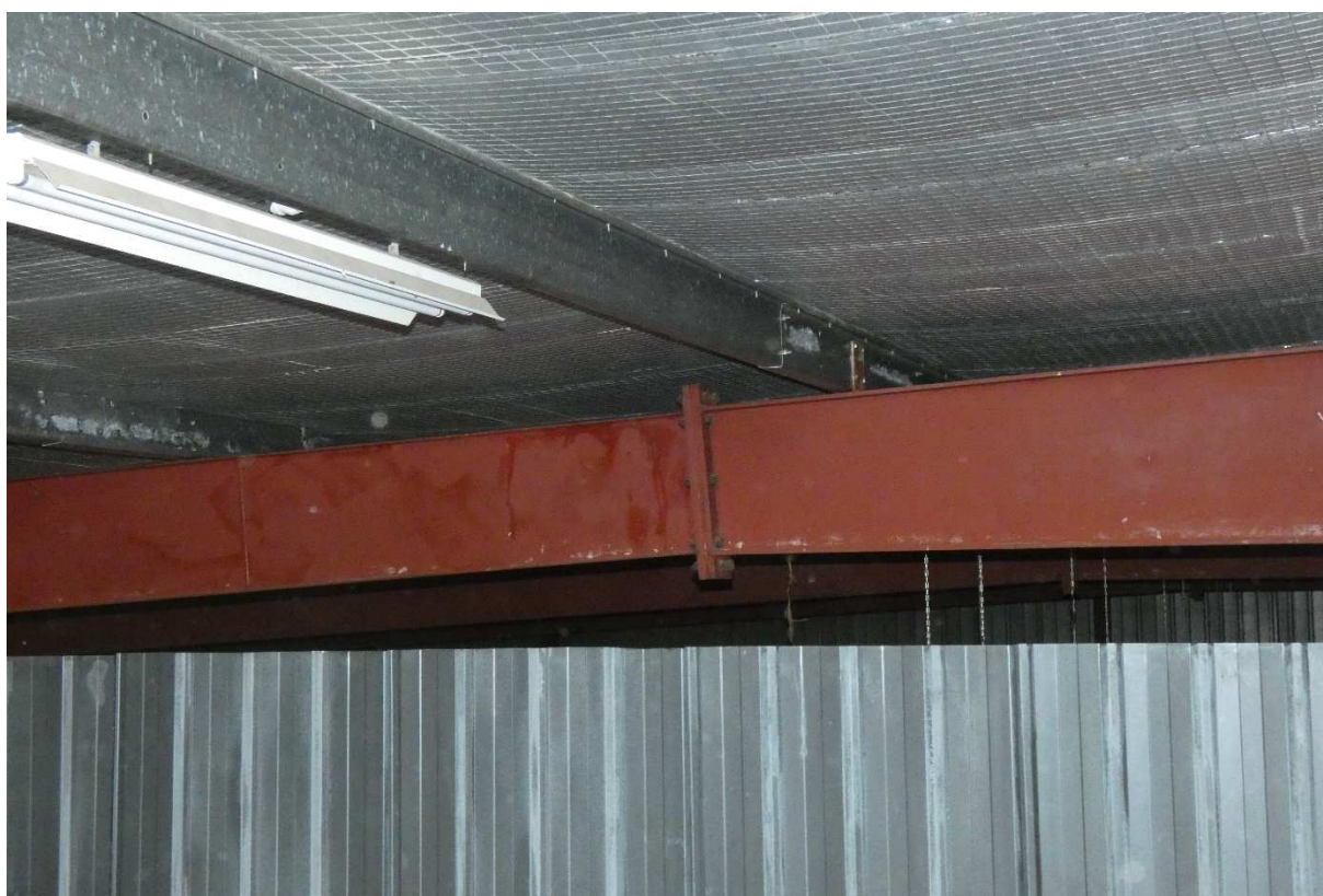
4- VUE DE L'ASSEMBLAGE AU FAITAGE
