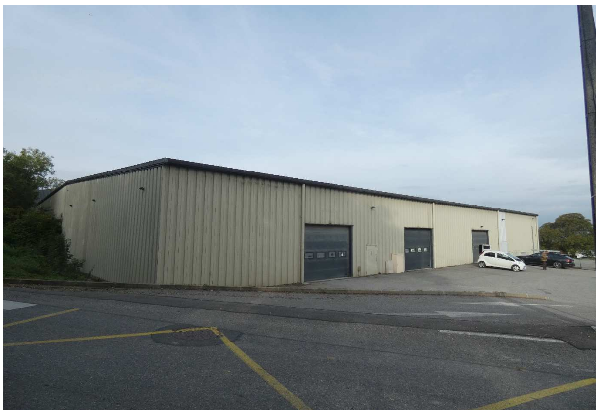
-1- VUE D'ENSEMBLE EXTERIEUR DE LA TOITURE
